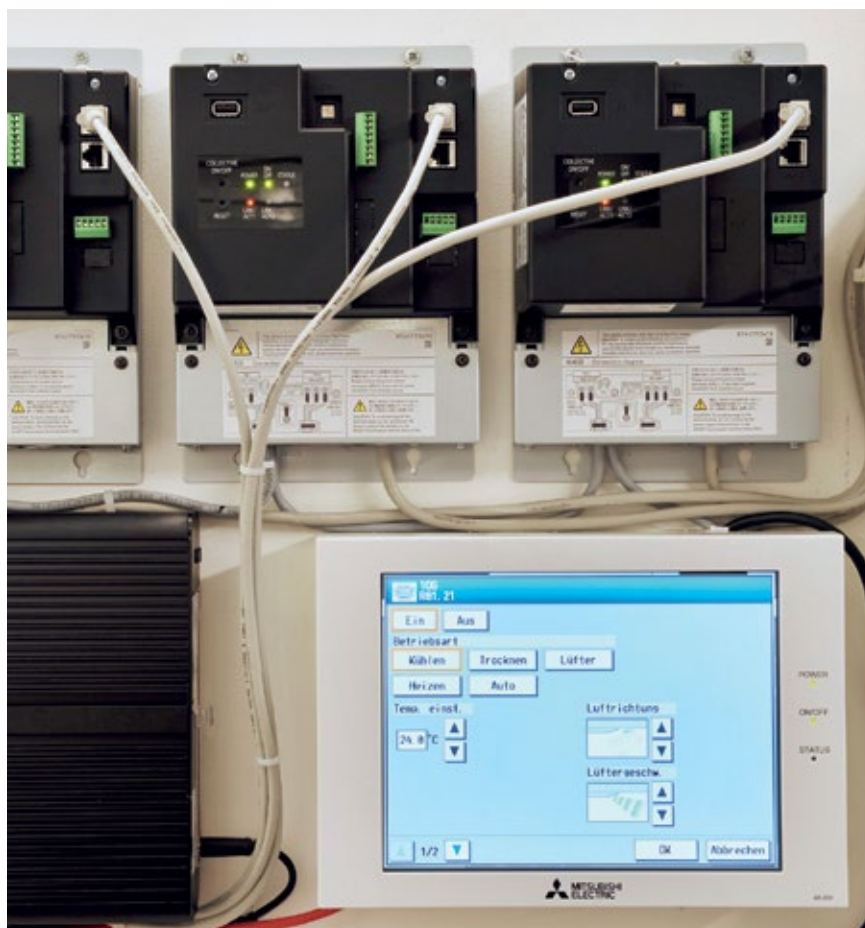
Wszystko pod kontrolą w jednym systemie: Za pomocą AE-200 można centralnie monitorować podłączone urządzenia wewnętrzne i sterować nimi.
